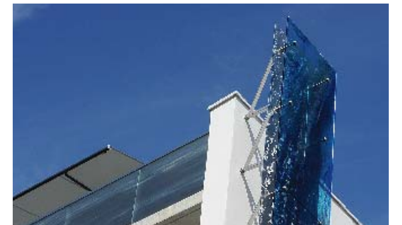
Installation de la première couche en inox ajouré sur la structure porteuse. Pose des feuilles de verre avec film PVB imprimé.
